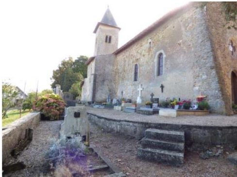
Mur de soutènement nord, 2016, photo Atelier Grégoire André
