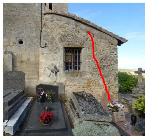
Fissure verticale, angle Nord Est de la sacristie, 2016, photo Atelier Grégoire André
