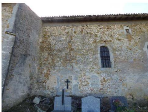
Fissures verticales, mur nord de la nef, 2016, photo Atelier Grégoire André
