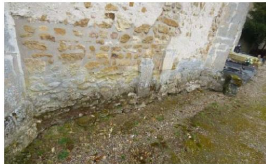
Déchaussement des fondations et lessivage des sols, 2016, photo Atelier Grégoire André
